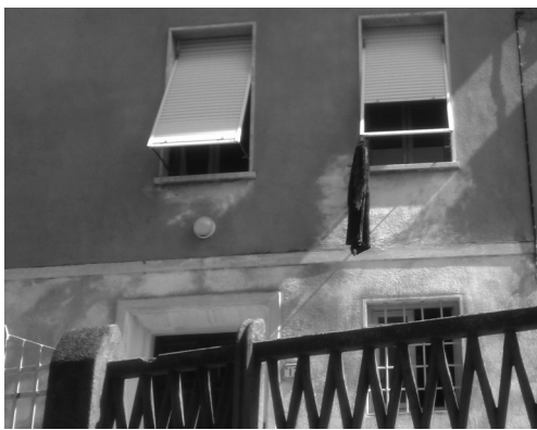
Un dettaglio della "casa della paura".
