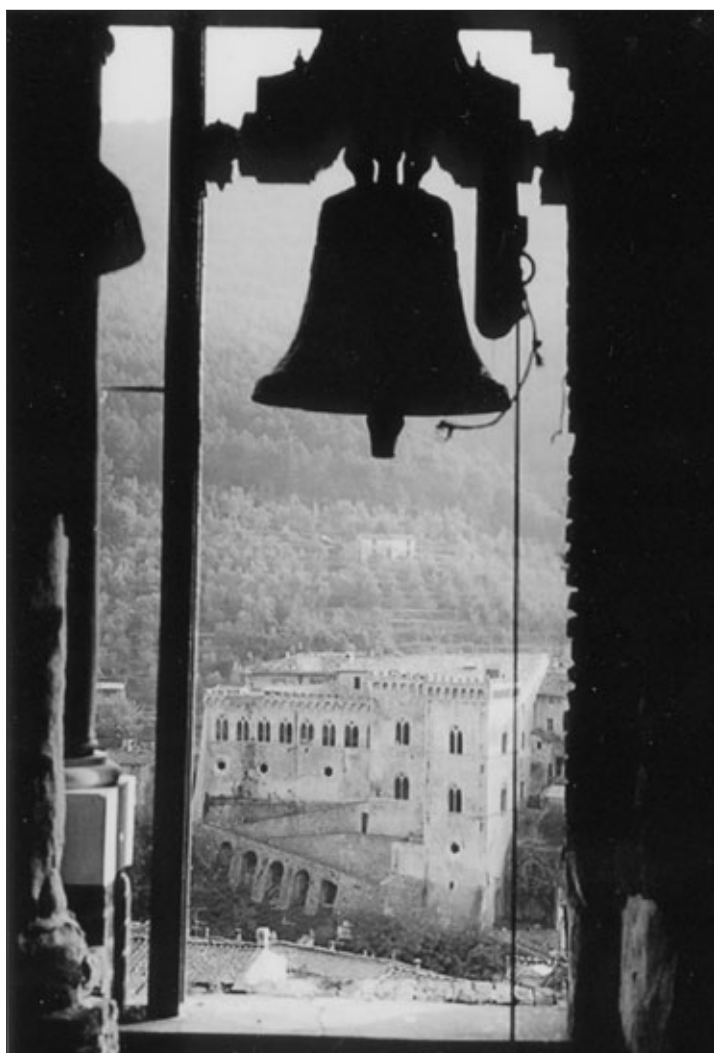
Buti - Castel Tonini. Vista dalla torre campanaria.
